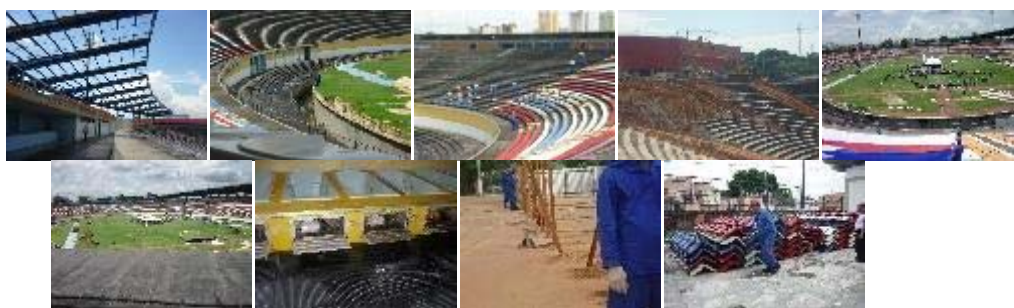
Retiradas e demolições
